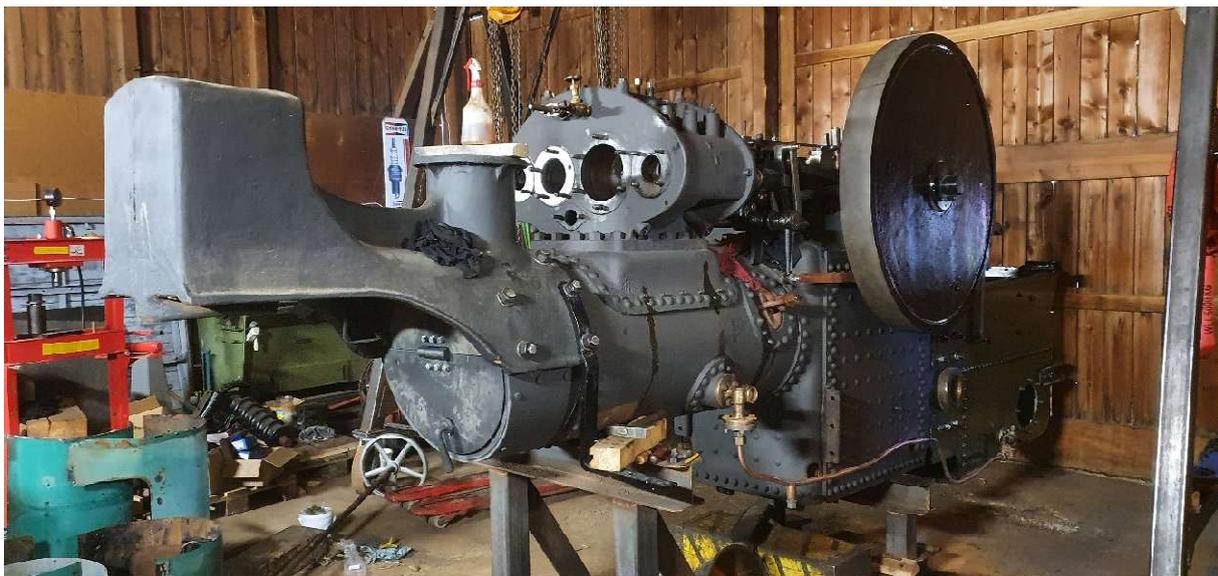
Anfang Juli bot sich dem Betrachter dieses Bild: Der Tender ist angebaut, die Rauchkammertür ist montiert und der Zusammenbau der Dampfmaschine hat begonnen. Nach über einem Jahr mit dem nackten Kessel auf den Böcken nimmt die Walze langsam wieder Form an, und ihre Länge wird auch immer ersichtlicher.
