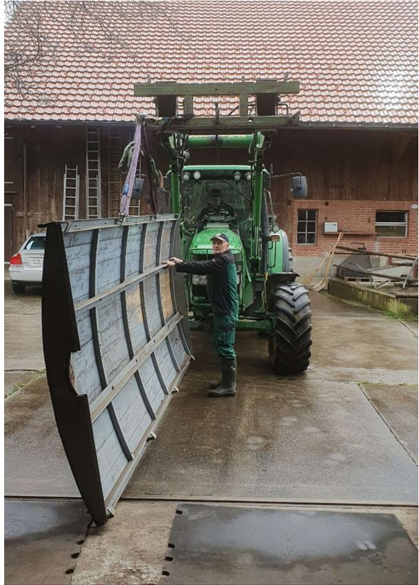
Das Dach wurde anschliessend am Kran hängend von der alten Farbe befreit. Die Stahlteile wurden mit Nadelhammer und Stahl-Topfbürste bearbeitet, das Holz zuerst mit einer Messing-Topfbürste von der Farbe befreit und dann mit dem Schwingschleifer wieder in Form gebracht.
