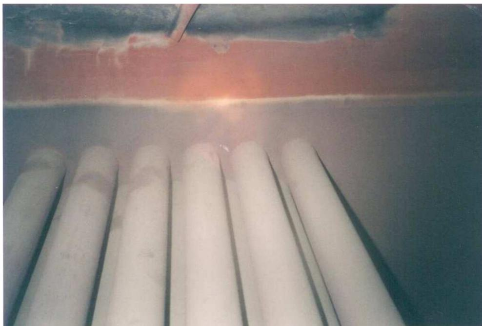
**2,5 t/h WULFF-Kessel, betrieben mit DEMKOR® 41.** Unterhalb der Wasserlinie bildet sich die braune, nicht wärmeübergangshemmende DEMKOR®-Schutzschicht flächig aus.
