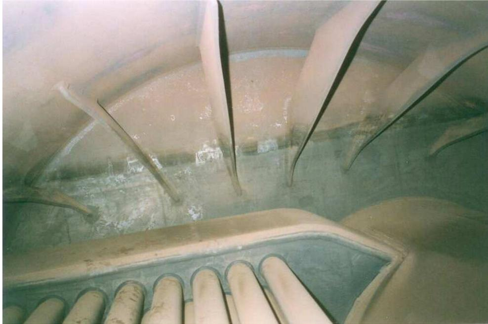
**7 t/h LOOS-Kessel, betrieben mit DEMKOR® 41 K.** Unterhalb der Wasserlinie wird die schwarze Magnetitschicht zusätzlich durch die braune, nicht wärmeübergangshemmende DEMKOR®-Schutzschicht geschützt. Oberhalb der Wasserlinie findet die Passivierung des Materials durch den dampfflüchtigen Kondensatschutz statt.
